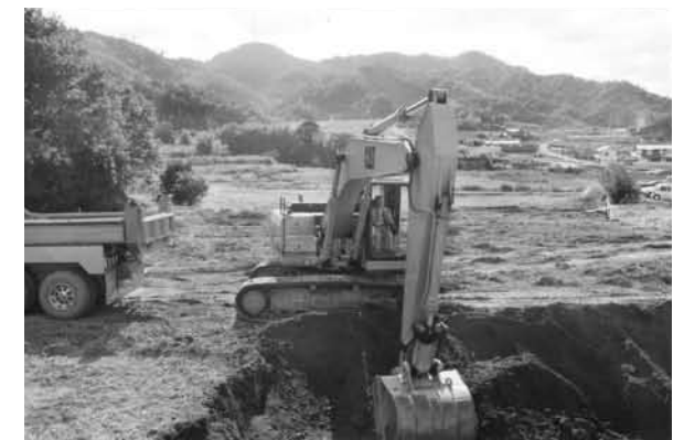
写真3 機械掘削状況（北から）
