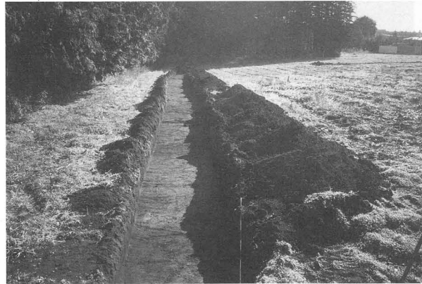
D T 全掘状況
