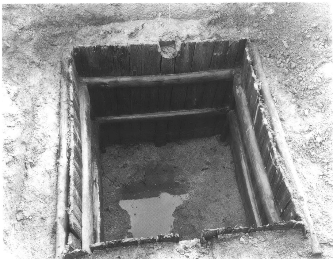
(2) SE101 (完掘) (北から)
