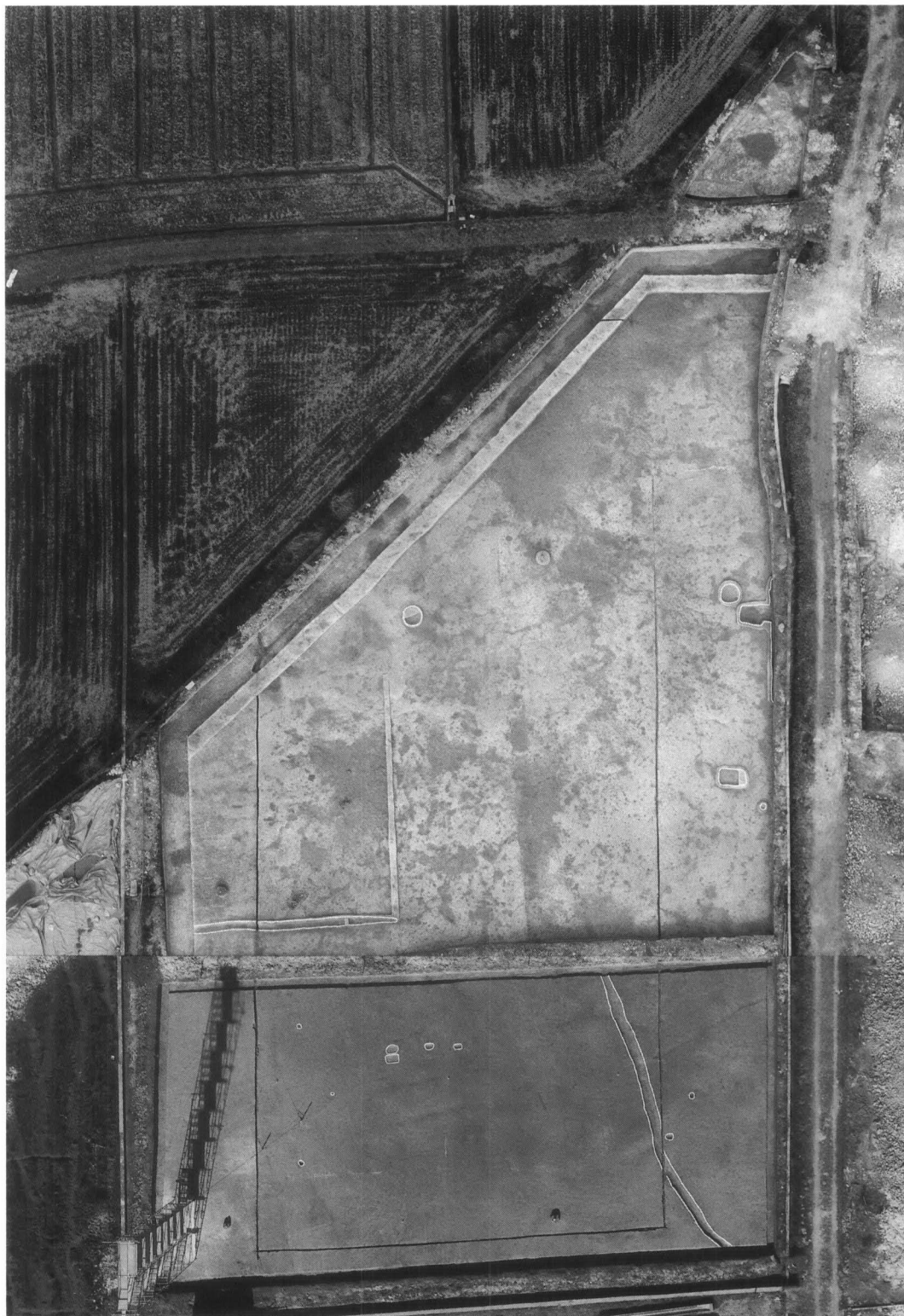
3区V 掘削終了状況（俯瞰）
