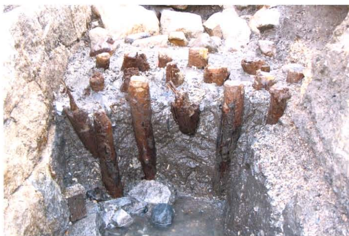
fig16. 埋め立て部分の杭列
