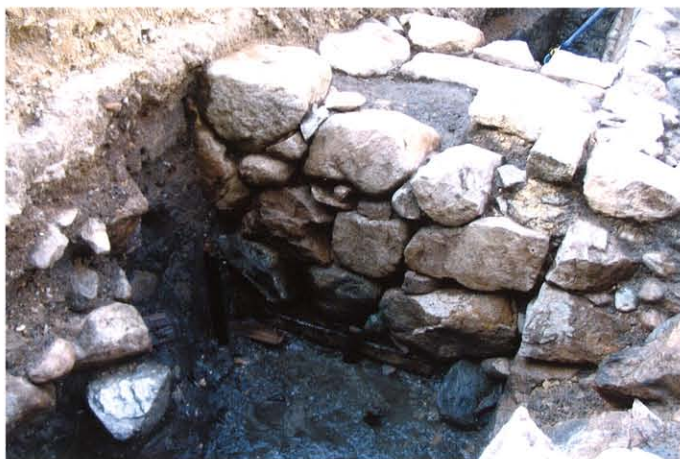
fig14. 埋め立て時の石垣
