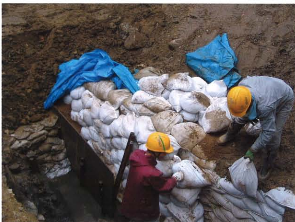
fig27. 石垣の埋め戻し保存
