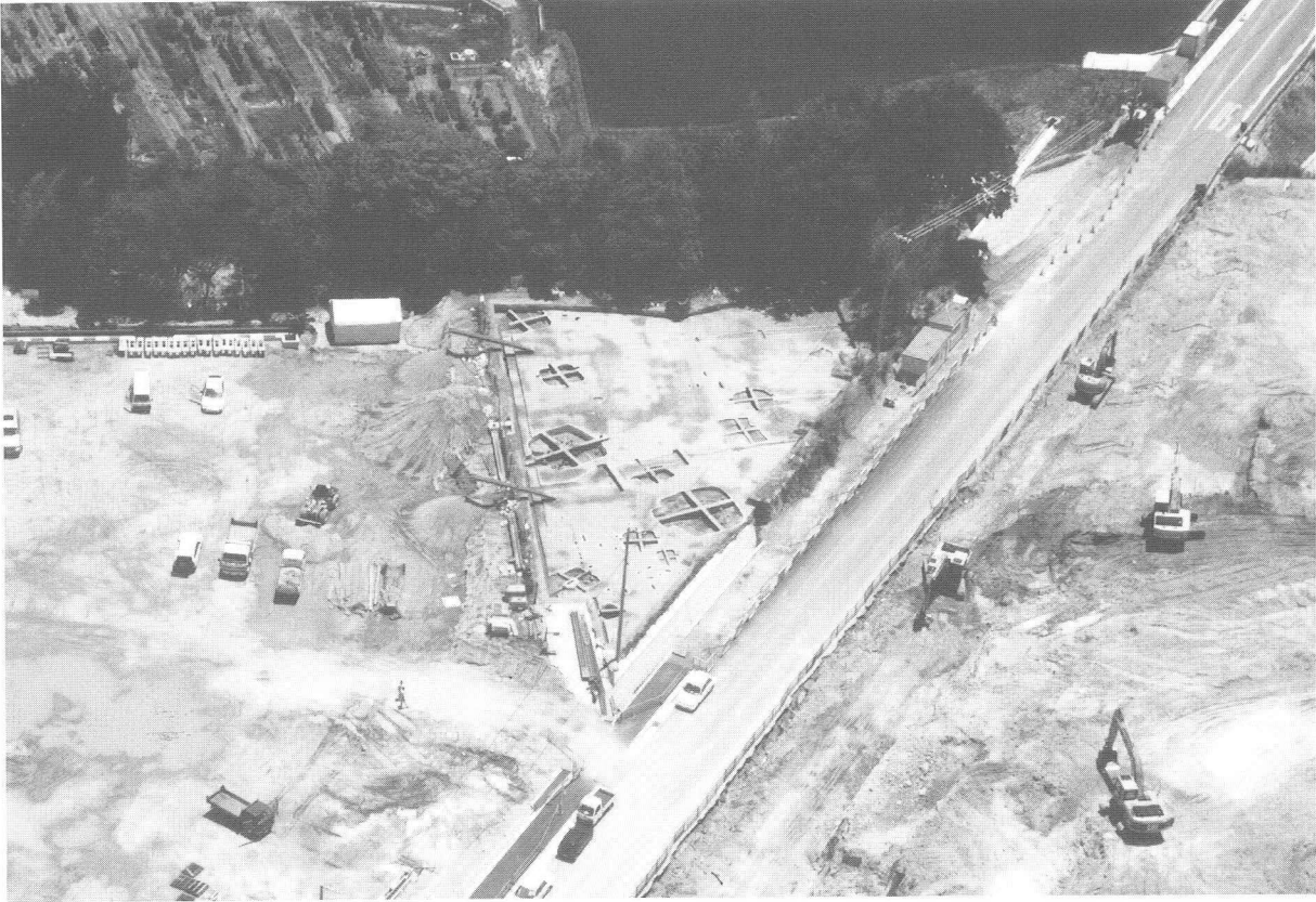
東段丘地区 掘削状況（西北上空から）
