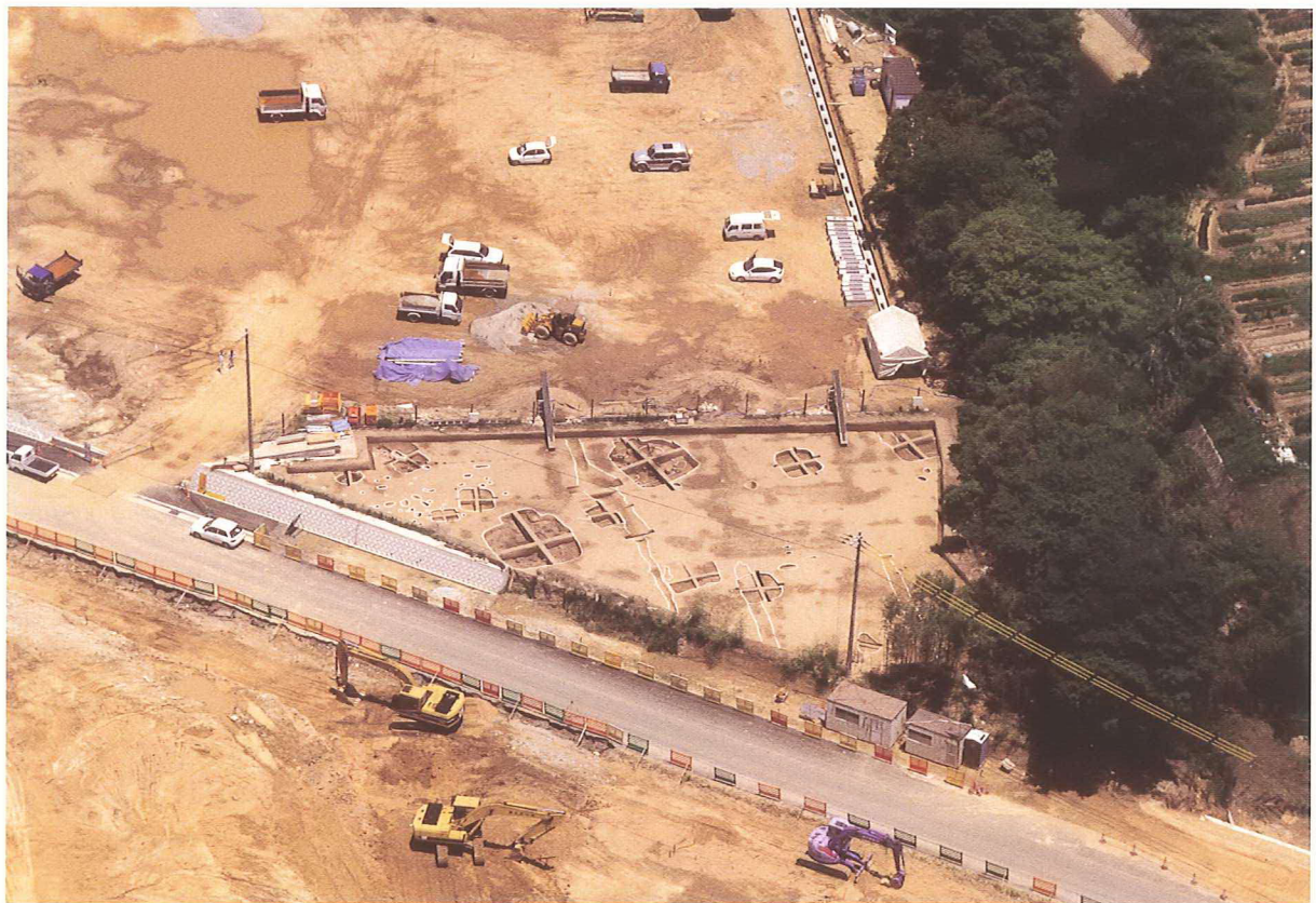
東段丘地区 掘削状況（西上空から）
