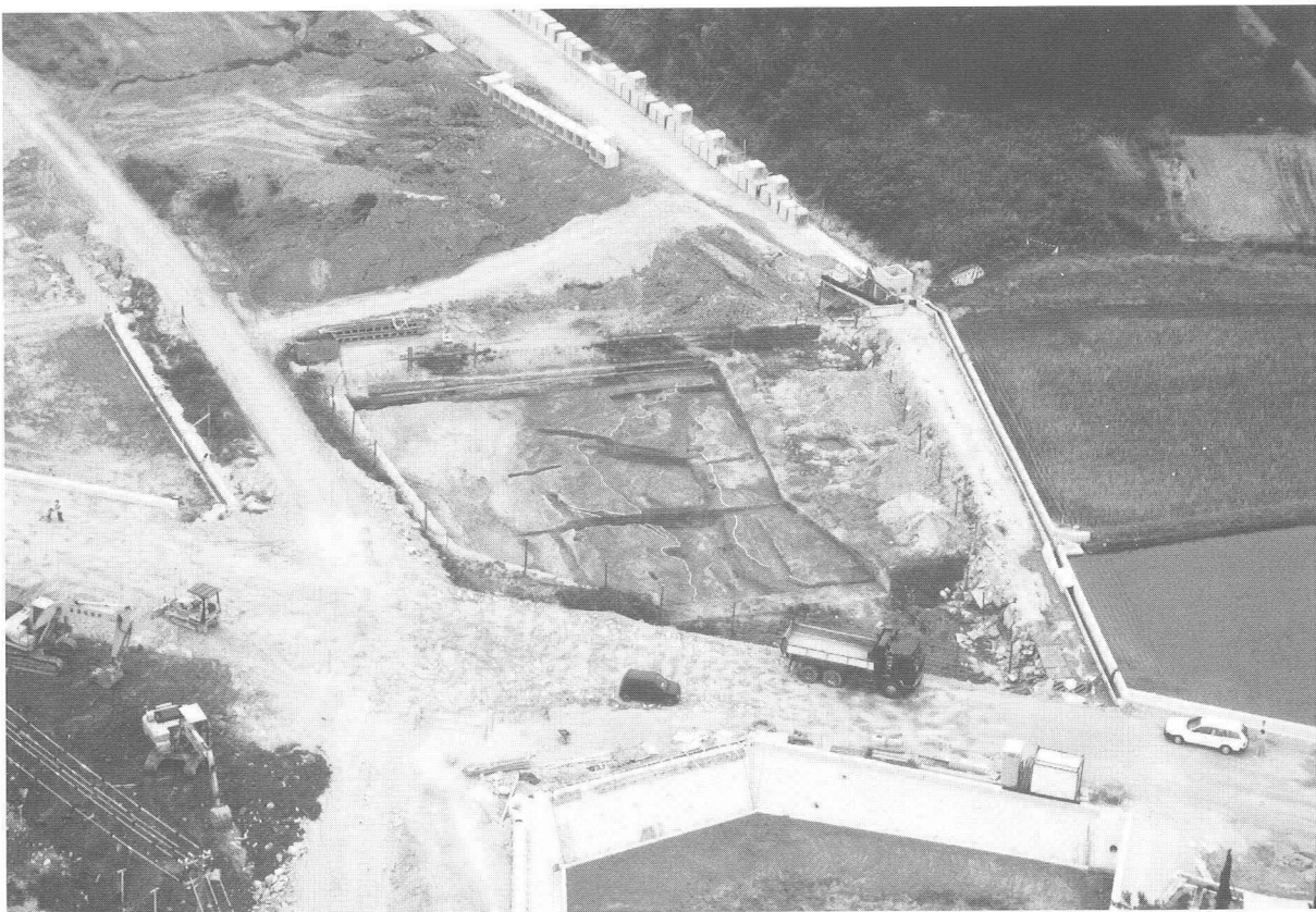
東谷地区 掘削状況（東北上空から）
