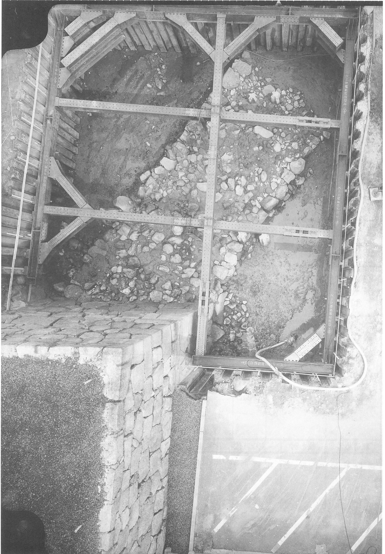
図版1 良櫓台および付属突堤全景
