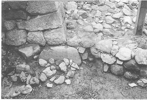
図版4 突堤取り付け部分（東から）
