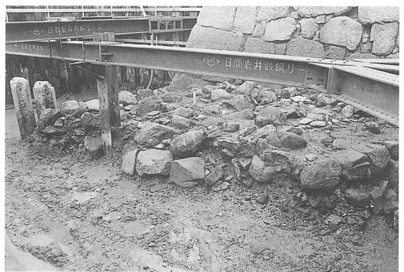
図版9 突堤断面（北より）
