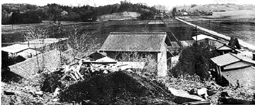
2. 本古墳から 東方の雷神山 古墳 (写真ほ ぼ中央)を見る
