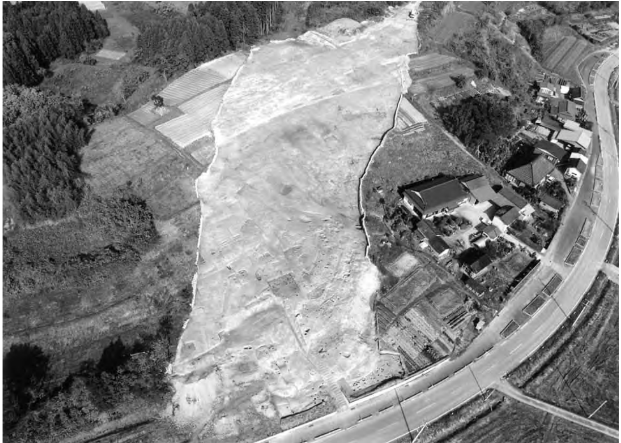
1. 調査区全景（I区） 南から
