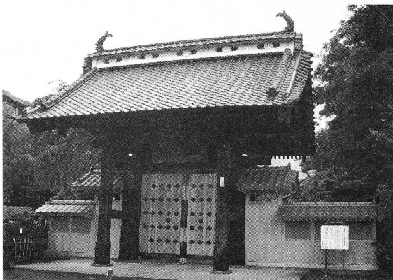
●修理が終了した泰心院山門
