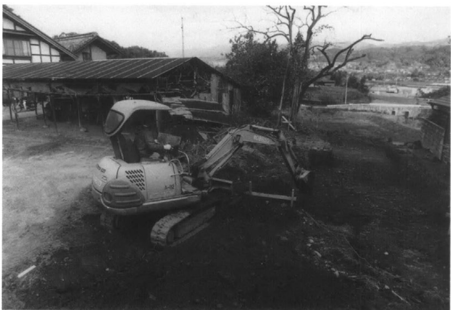
重機作業風景
