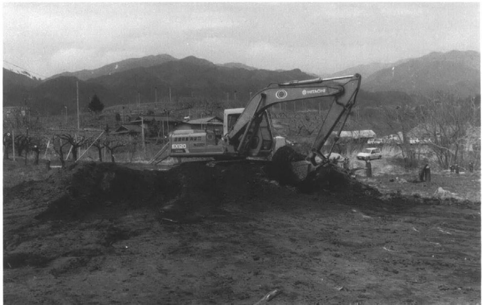
重機作業風景
