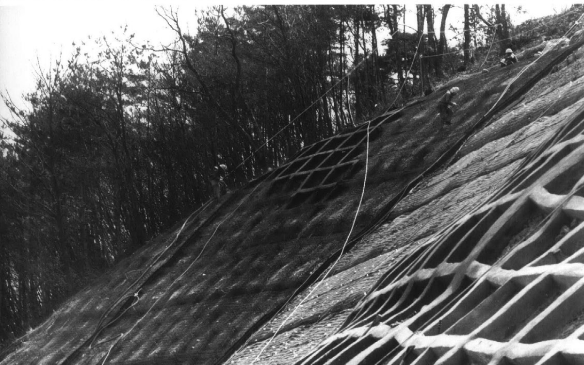
法枠工事 盛土後、コンクリート法枠を打設し、種子吹付けを行った。 (西から)
