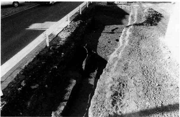
Ⅲ-A区全景（東から）
