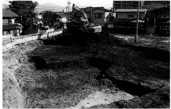
B区表土除去
