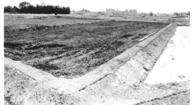
南西から 工事後
