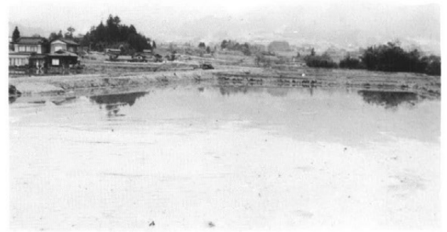
東から 工事後
