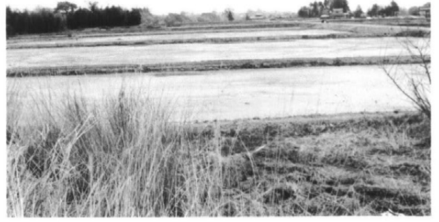
西から 工事後
