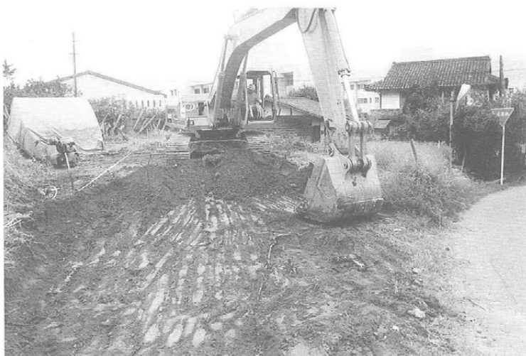
重機による表土剥ぎ
