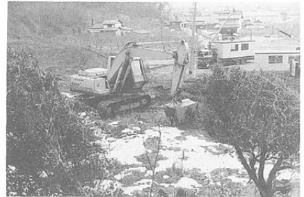
第197図 表土掘削状況
