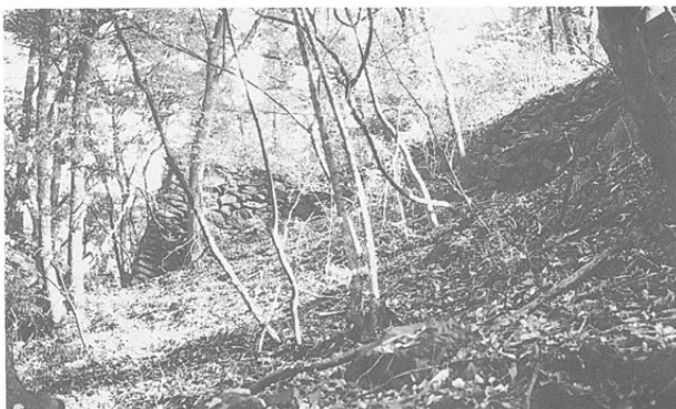
第11図 霞城石垣 (突出部)
