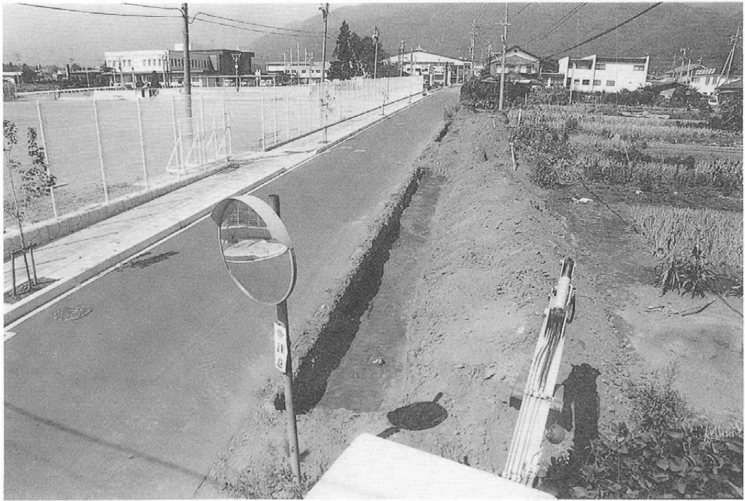
南側調査状況
