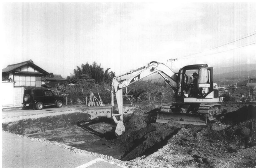
重機作業風景
