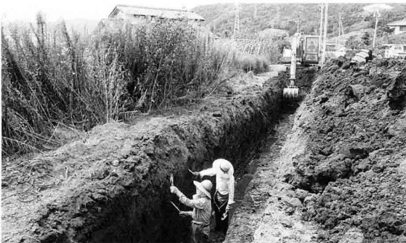
D地区 試掘坑
