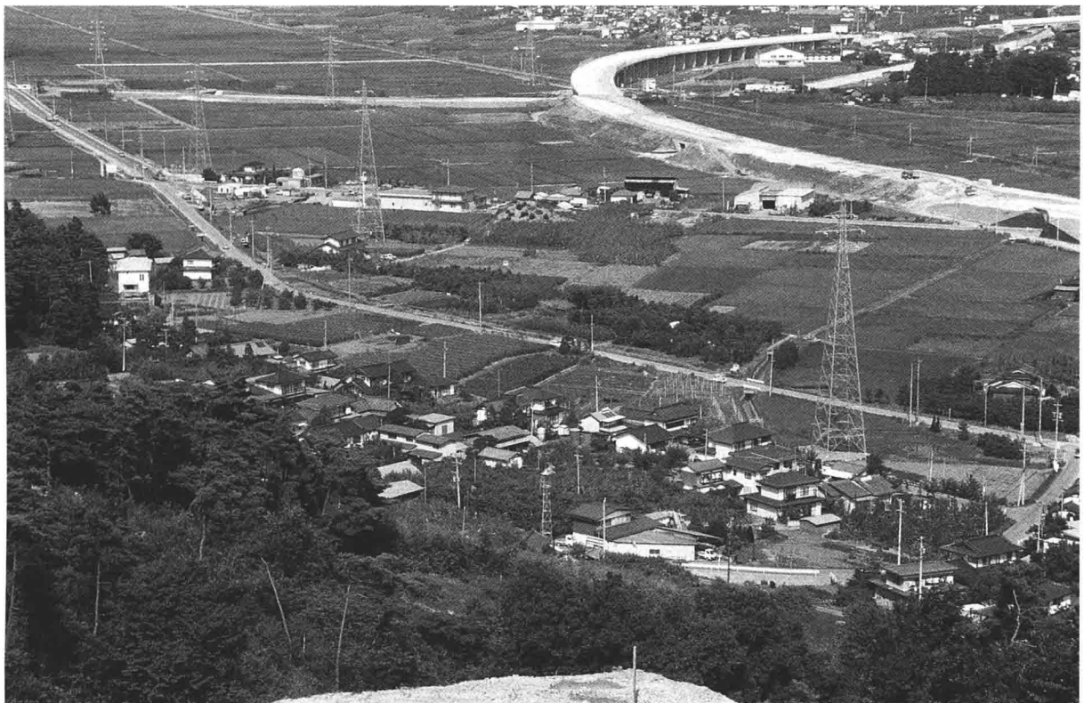
調査地の遠景（西から）
