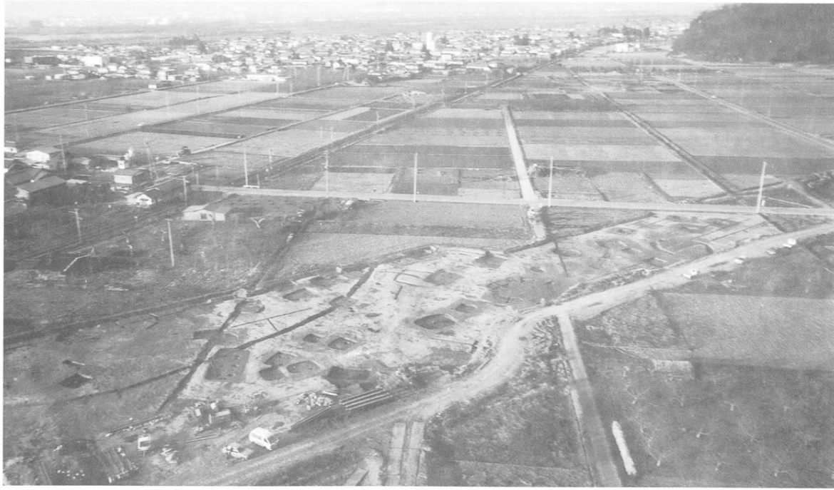
IV区調査区全景 (上空南東より)
