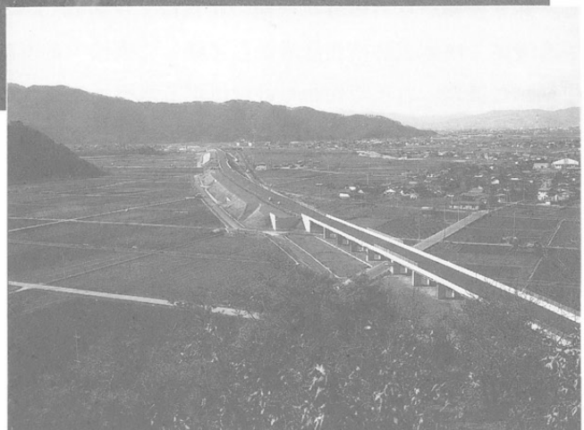
高速道建設後の周辺
