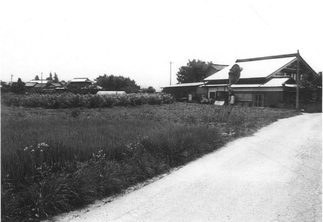
HSZ 調査前 (南西から)
