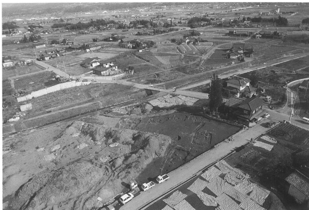
DUG IX 全景 (斜め上空から)
