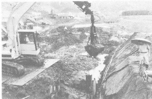
第6図 クラムシェルによる試掘
