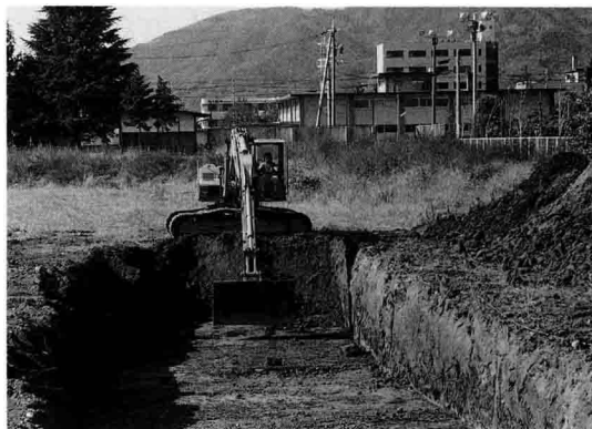
I-2 重機による表土剥ぎ（A区）
