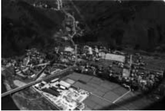
塩田若宮遺跡（南西から）
