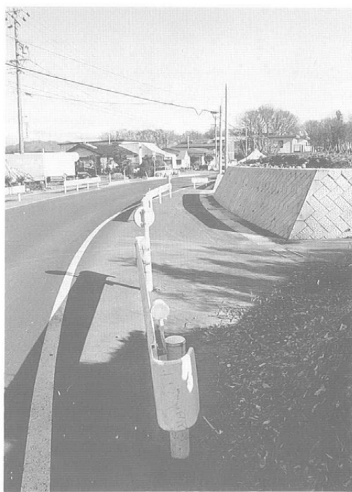
写2 寺中遺跡工事終了状況（西から）
