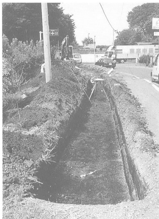
写1 寺中遺跡試掘状況（東から）
