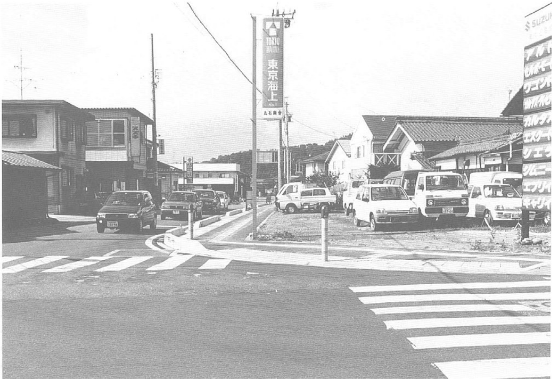
工事完成風景 (南より)
