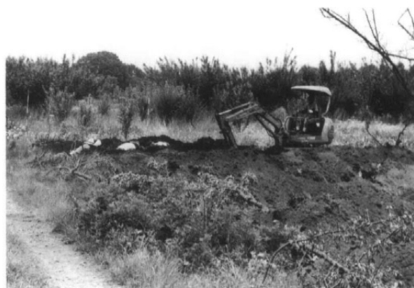
重機にて試掘調査
