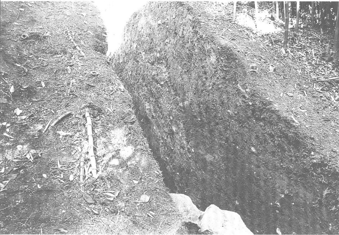
土塁断面 (東側より)
