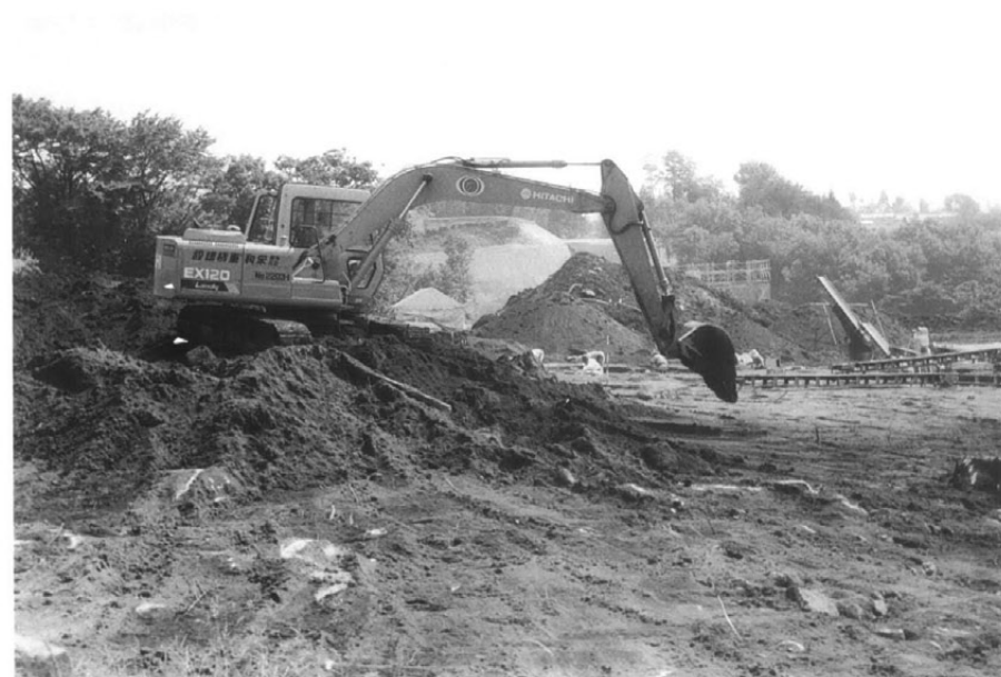
重機作業風景
