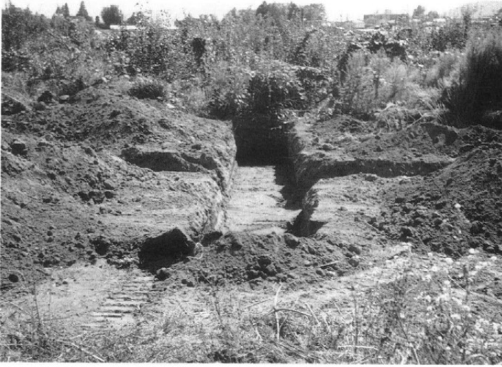
試掘トレンチ 掘上げ状態
