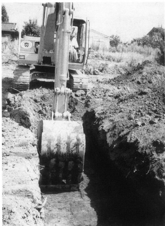
トレンチによる試掘調査
