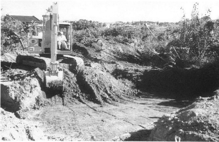
重機による 表土剥ぎ作業
