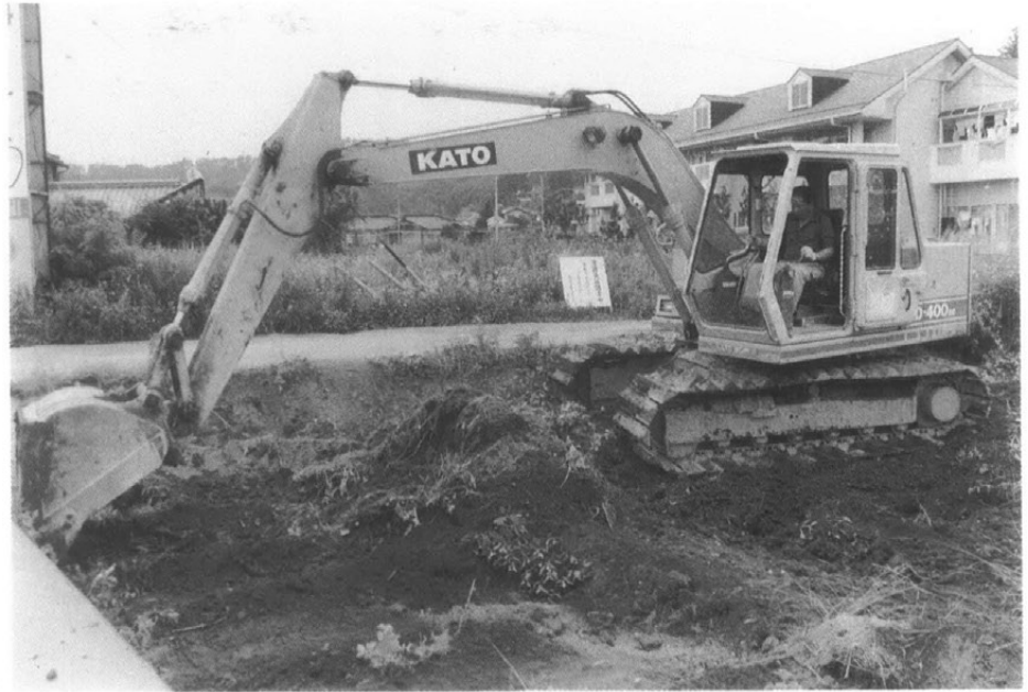
重機作業風景
