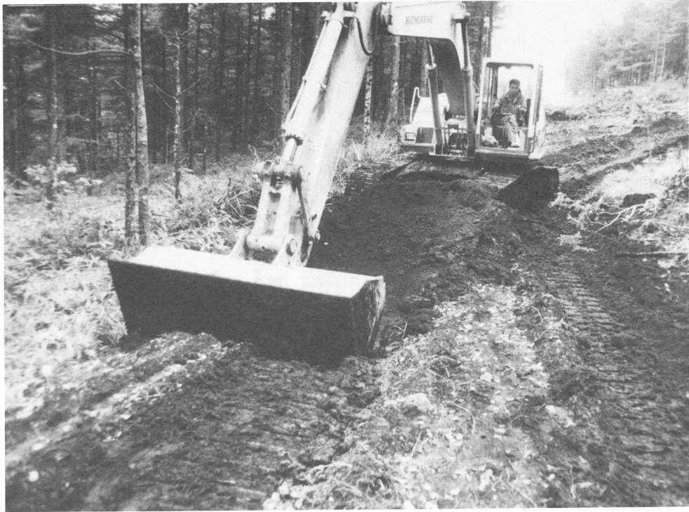
重機による遺構確認のための表土剥ぎ作業（K R B 地区）
