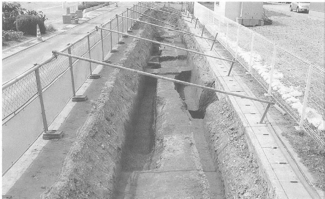
城ノ内遺跡調査区西半部 (北側より)
