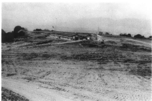
大原遺跡 工事終了後 — 東より
