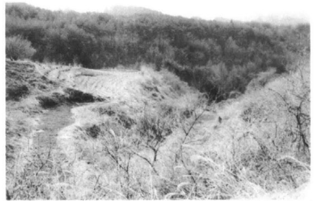
岩沢支流の谷頭浸蝕部 — 上から（北より）
