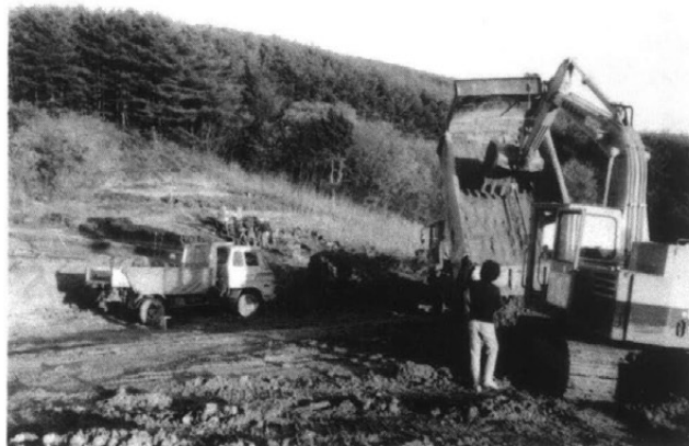
富田窯址ぎわに工事がせまる
