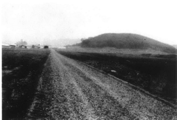
大原遺跡 工事終了後 — 西より
