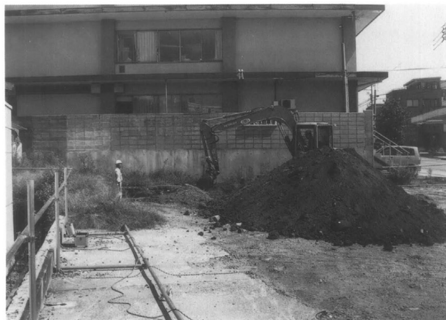
重機作業風景
