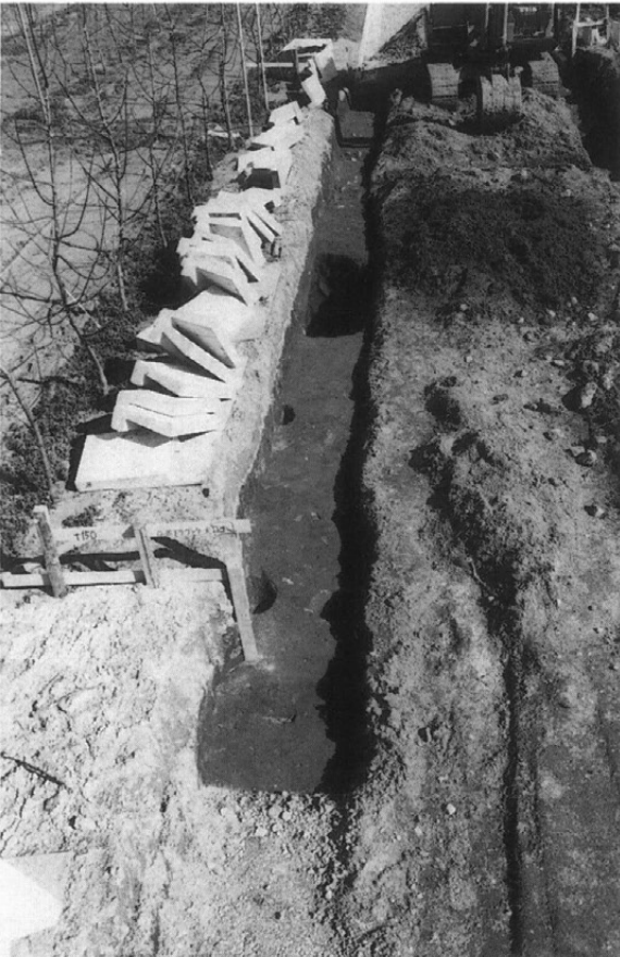
第 XV 地区北西側トレンチ全景 (北西から)
