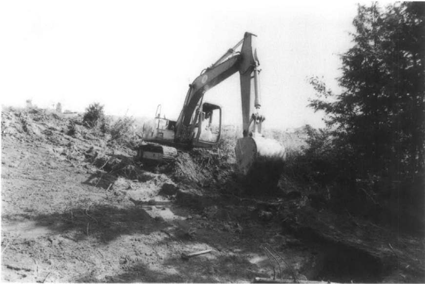
重機作業風景
