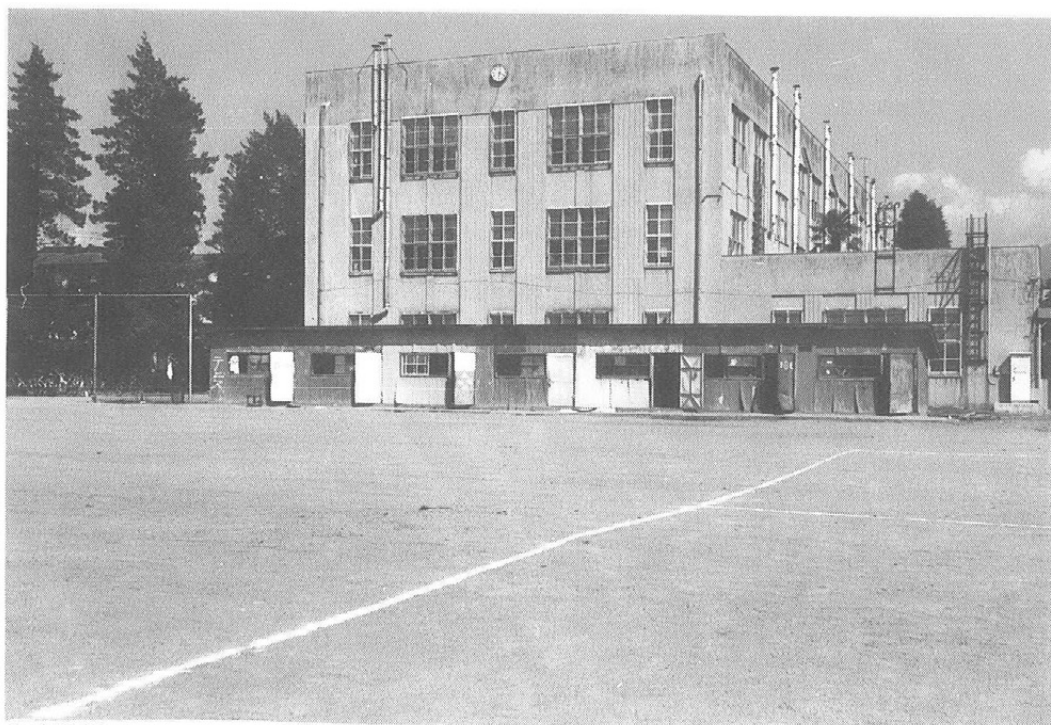
調査地近景（西より望む）
