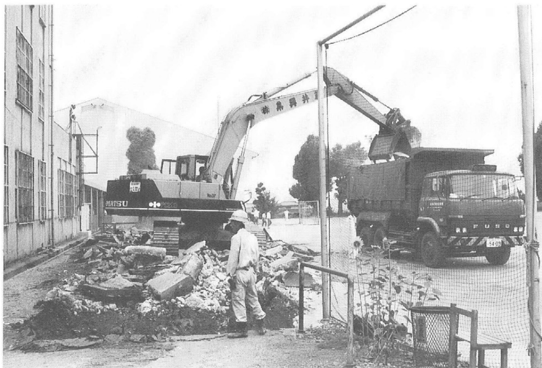
重機による部室取り壊しスナップ
