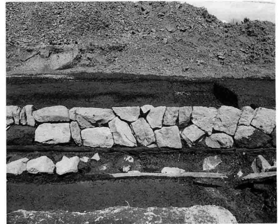
Ⅲ-8 2号石積み立面 (部分)
