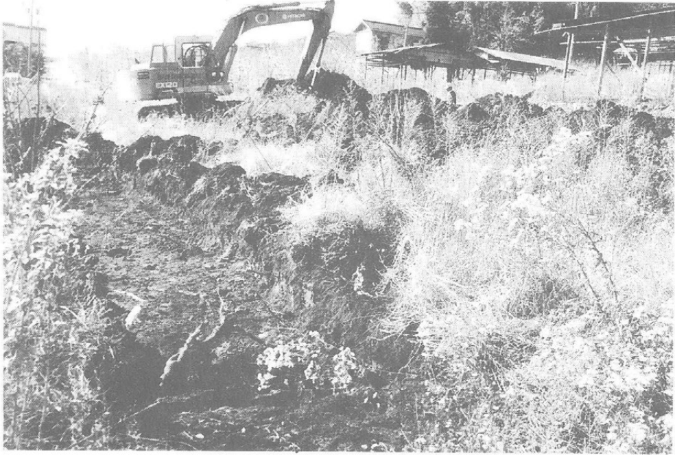
重機作業風景
