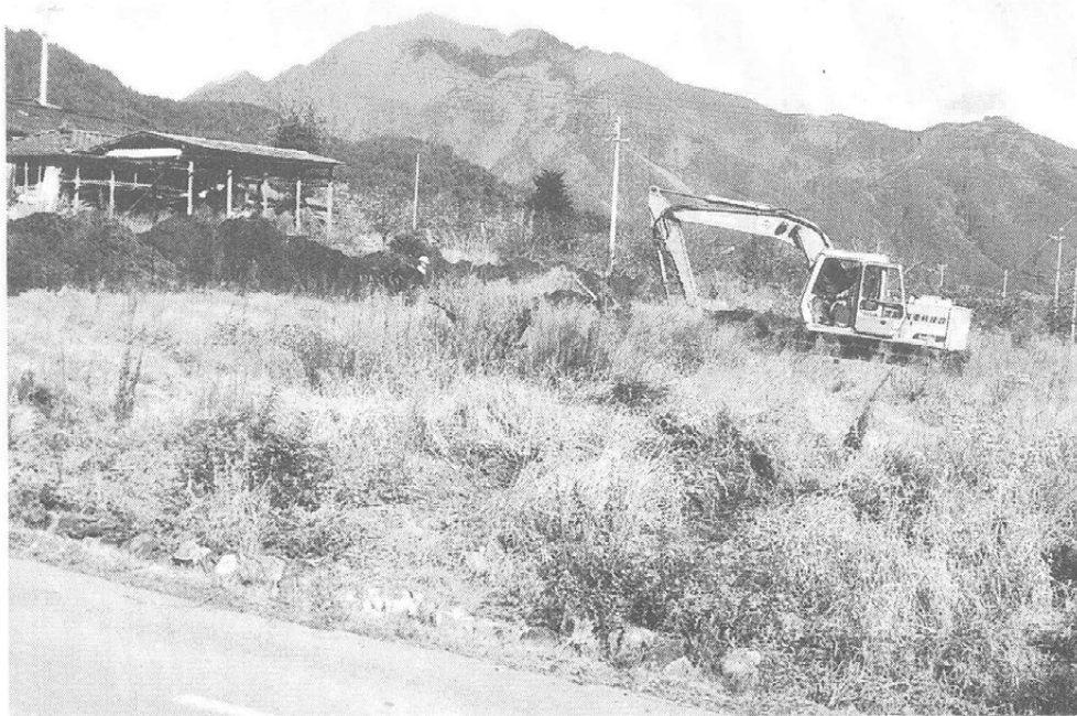
重機作業風景
