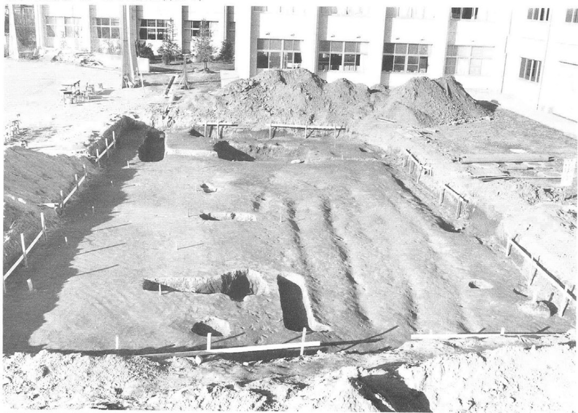
部室棟部分全景(南より)
