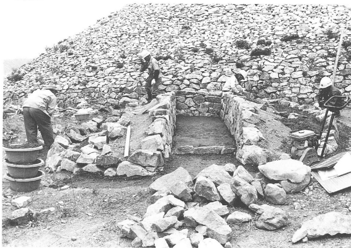
3号墳の復原工事（南側より）
