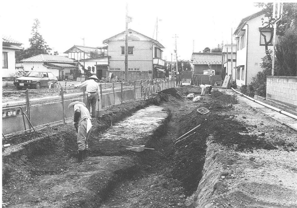
調査区北側調査風景
