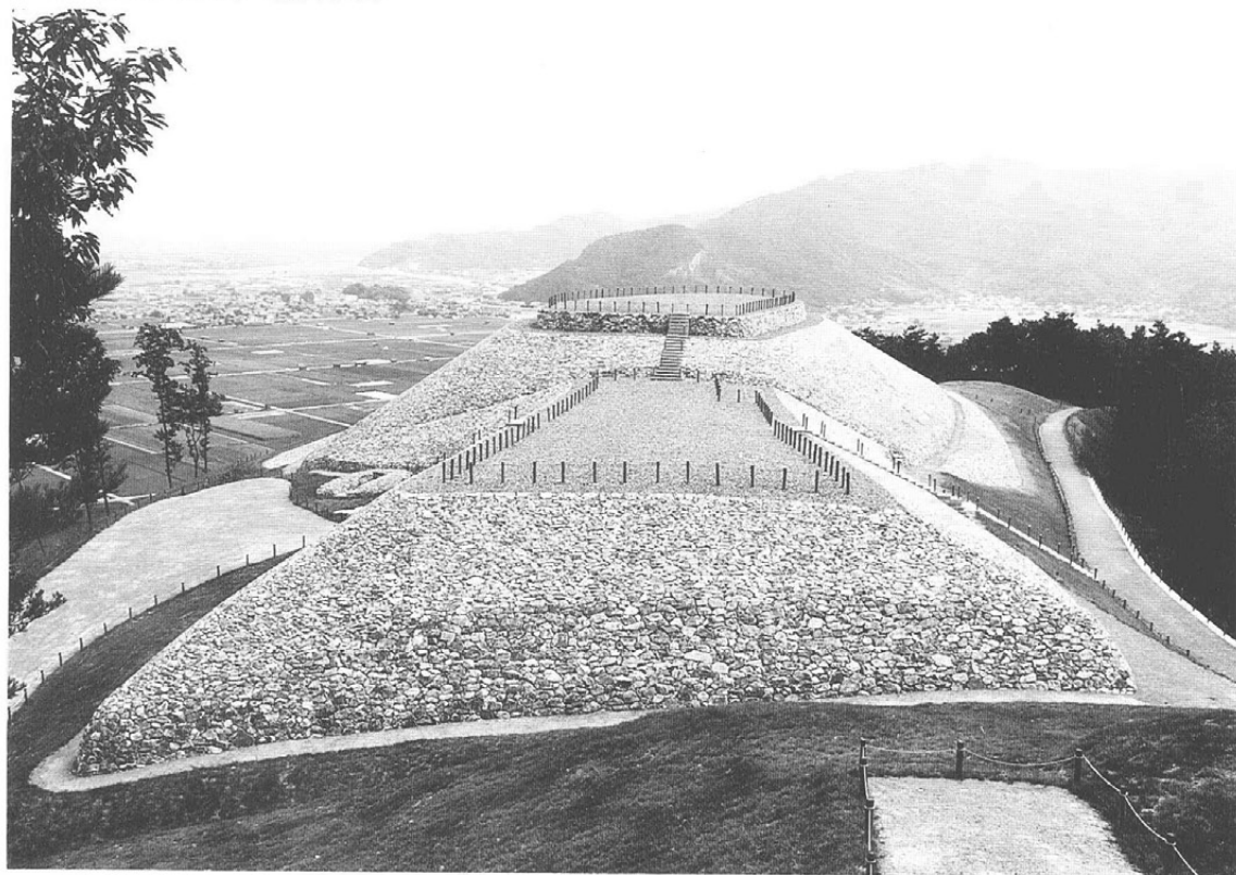
古墳本体復原工事完了（南側より）
