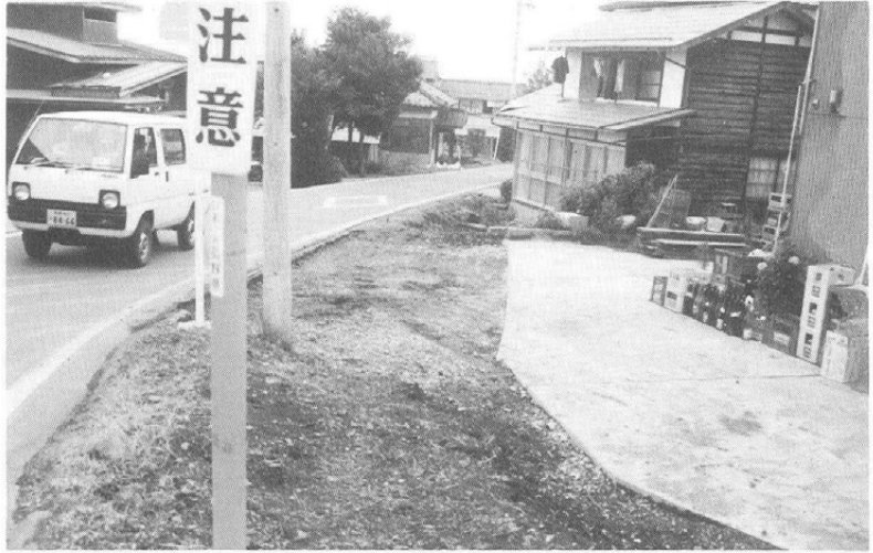
▷ 発掘前の状況(2) 発掘のため舗装部分除去
