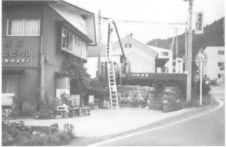
▷ 発掘前の状況(1) コンクリート舗装部分
