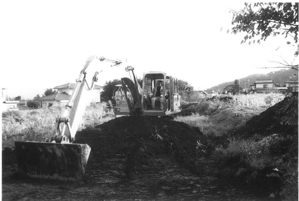
重機作業風景
