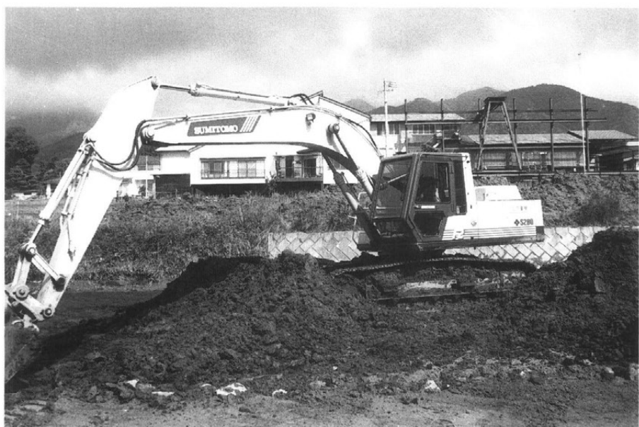
重機作業風景
