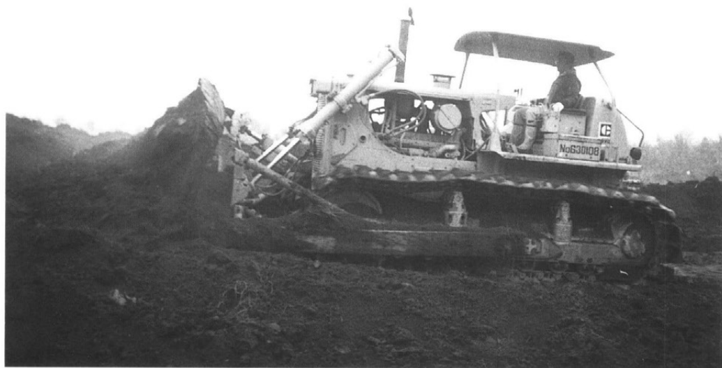
重機作業風景
