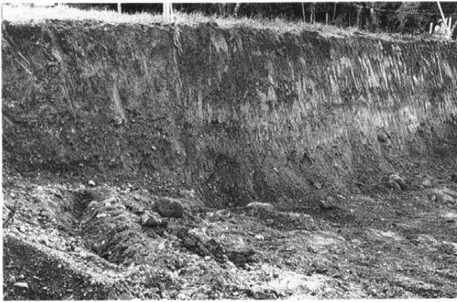
浸蝕谷を終わって現在の道を掘りこみ、 新しい道の路面まで掘り下げた南側の断面
