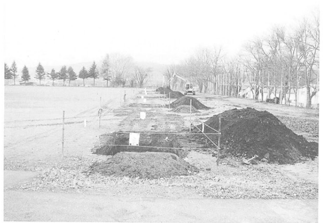
2.柳原遺跡 重機による埋め土の除去
