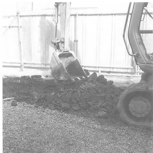
トレンチ掘削状況
