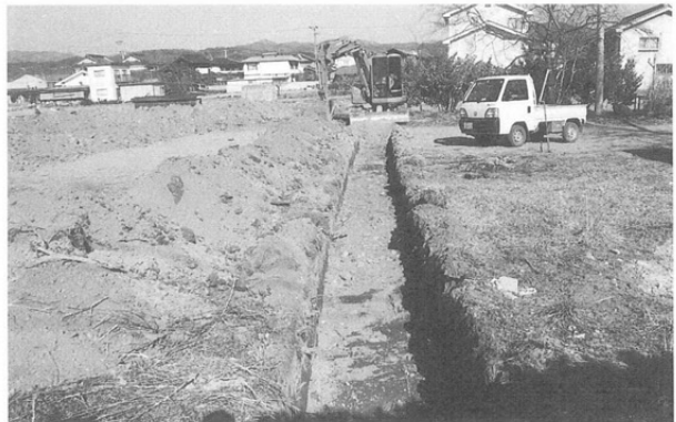
新町遺跡調査地点 (北方から)
