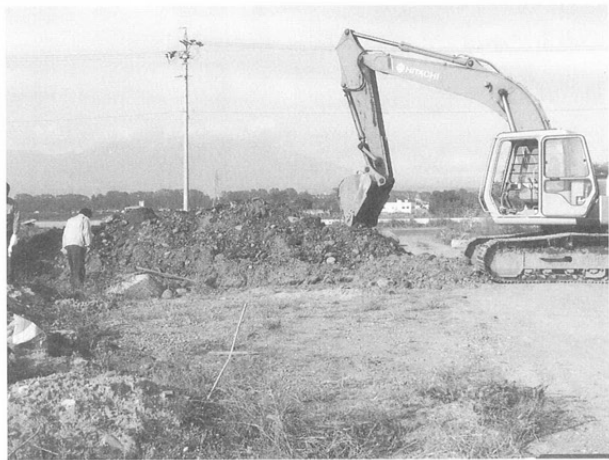
跡部儘田遺跡・跡部町田遺跡調査近景（南方から）
