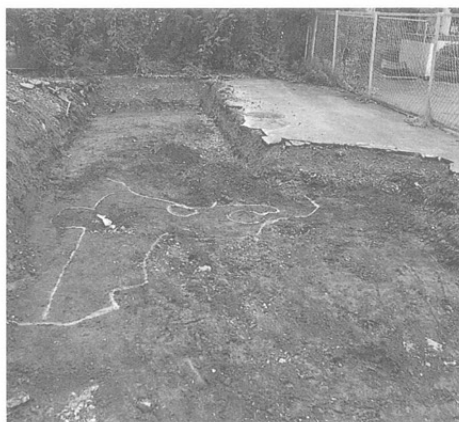
トレンチ掘削状況
