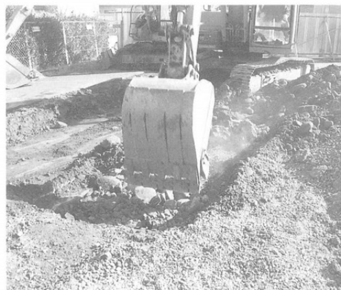
トレンチ掘削状況
